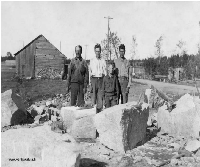
Eero (oik.) ja Alpo (vas.) jatkoivat suvun kivityöperinnettä. Tämä kuva on otettu kälviäläisellä siltatyömaalla.
